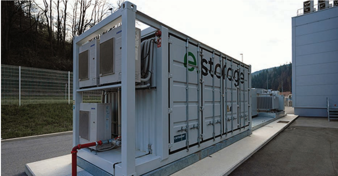
Slika 4: Primer izvedbe ohišja hranilnikov električne energije, vir: https://www.tab.si/
