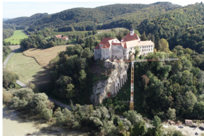
Sanacija skalne brežine »Grad Borl«
