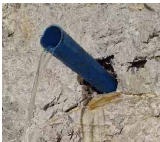
Slika 5: Iztok iz drenažne vrtnine na območju Goliškega preloma in uporabljen podporni tip pri prečanju območja preloma. Discharge from the drainage borehole in the area of the Goliško Fault and the support type used for crossing the fault zone.
