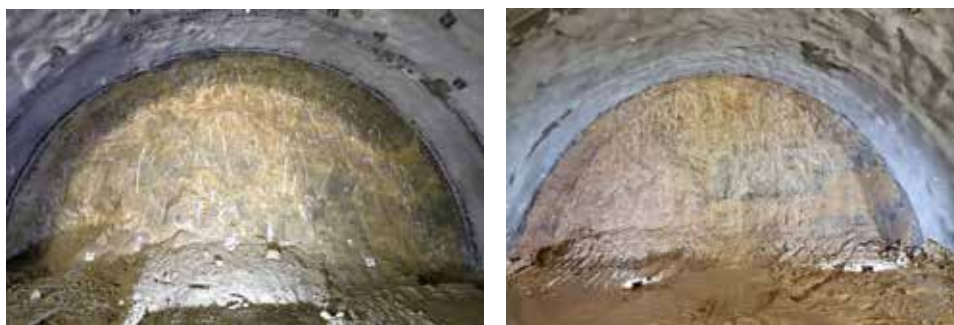
Slika 4: Primerjava izkopnih čel v peščenem meljevcu s podrejenim dolomitom in v pretežno dolomitni hribini s podrejenim peščenim meljevcem.
