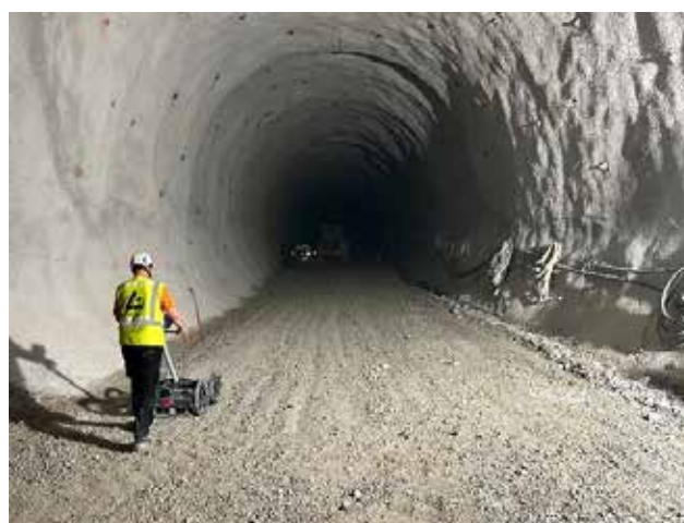
Slika 3: Izvedba meritev s talnim georadarjem (vir: lasten vir).
