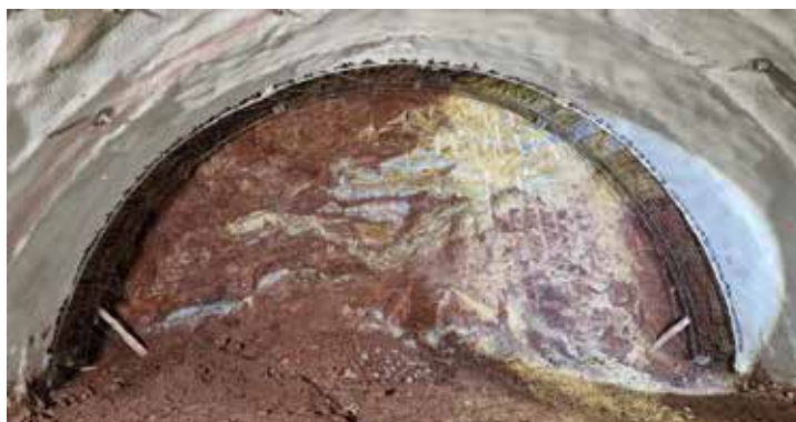
Slika 9: Izkopno čelo in talni obok v rdečem meljevcu z vložkom rumenega peščenega meljevca. Excavation face and floor arch in red marl with an interlayer of yellow sandy marl.
