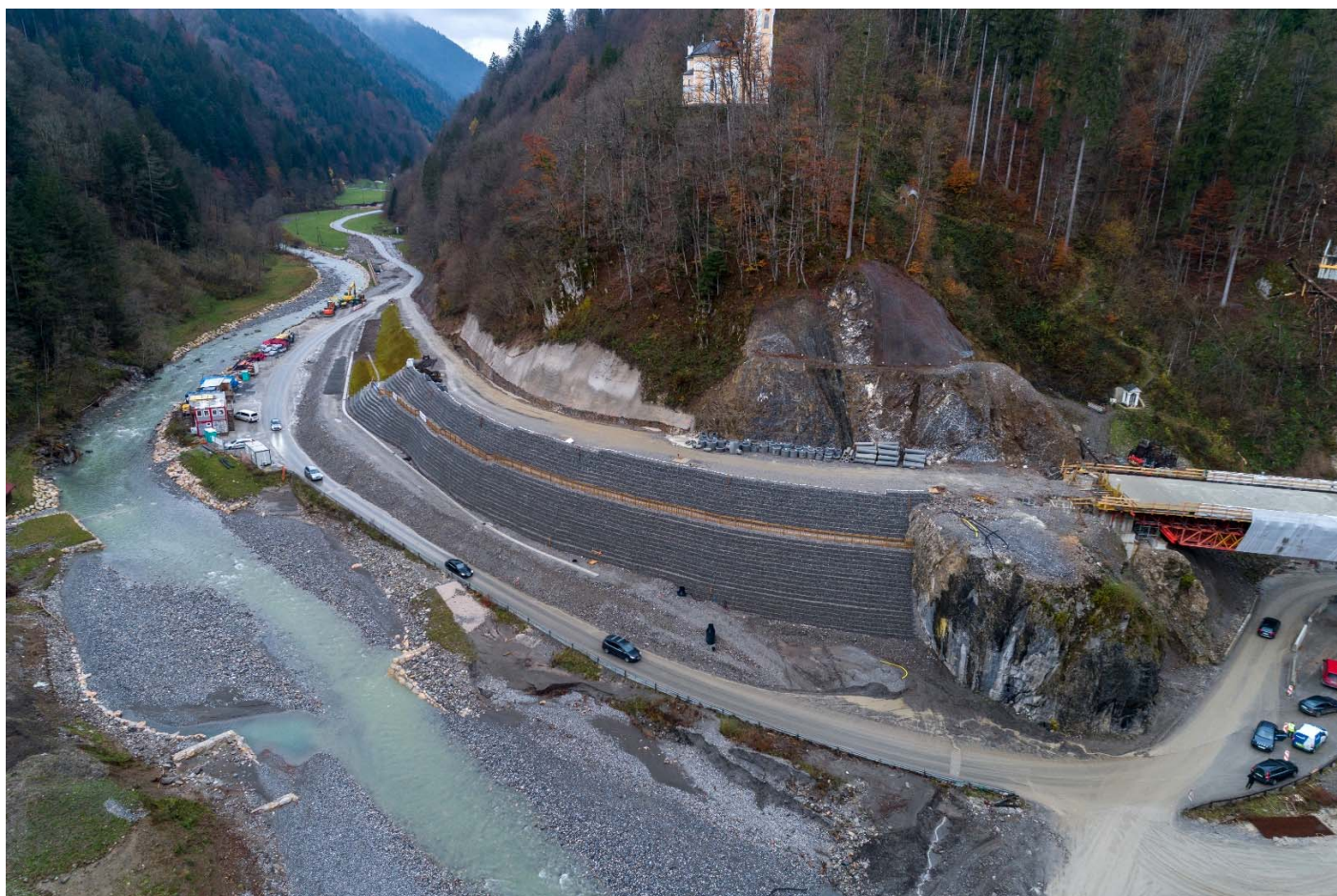
Sliki 16 in 17: Gradnja gabionskega zidu, nad katerim bo potekala prestavljena regionalna cesta (Foto: Karolina Korenčan)
