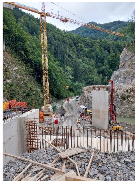
Slika 11: Pogled s krajnega opornika na gradnjo vmesnega opornika mostu (Foto: Karolina Korenčan)
