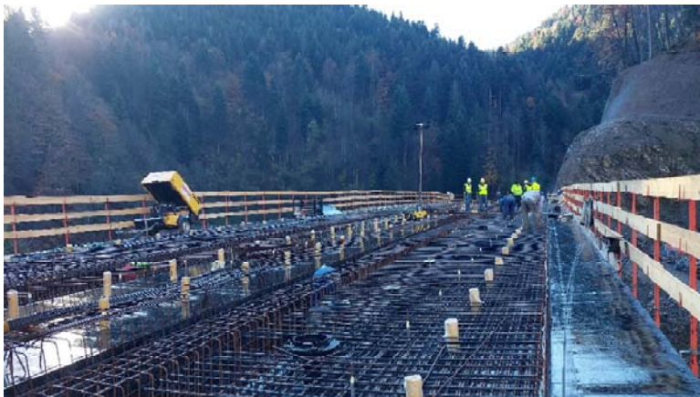
Sliki 12 in 13: Opažanje in polaganje armature prekladne konstrukcije mostu (Foto: Karolina Korenčan)
