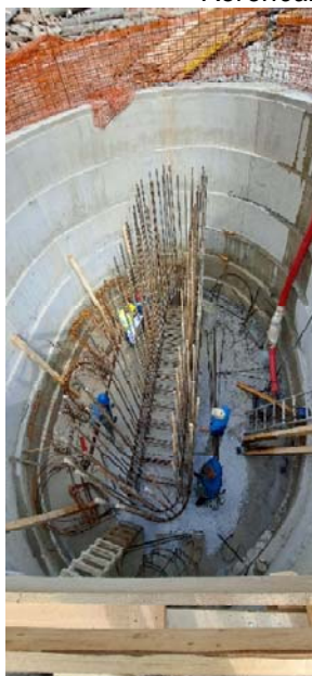
Sliki 9 in 10: Gradnja vmesnega opornika v vodnjaku (Foto: Karolina Korenčan)
