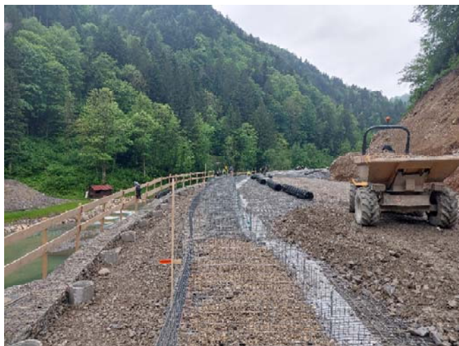
Sliki 16 in 17: Gradnja gabionskega zidu, nad katerim bo potekala prestavljena regionalna cesta (Foto: Karolina Korenčan)
