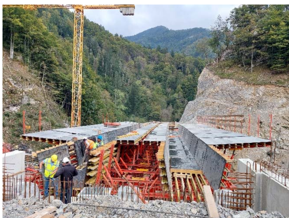
Sliki 12 in 13: Opažanje in polaganje armature prekladne konstrukcije mostu (Foto: Karolina Korenčan)
