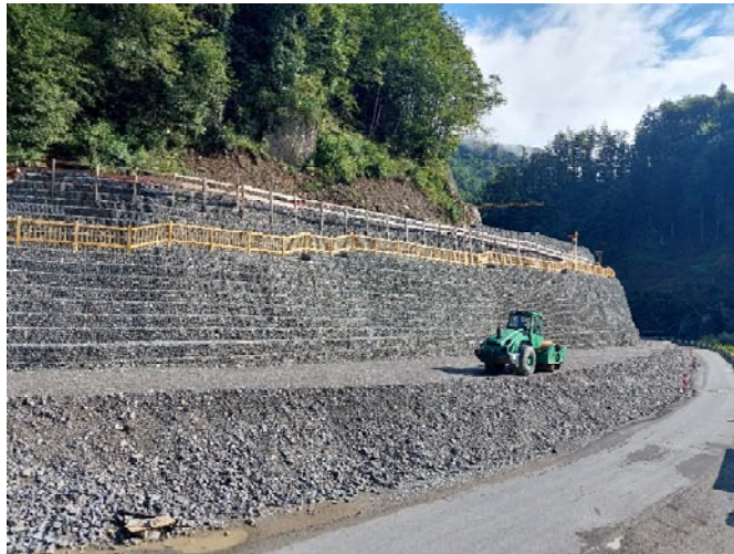
Sliki 16 in 17: Gradnja gabionskega zidu, nad katerim bo potekala prestavljena regionalna cesta (Foto: Karolina Korenčan)
