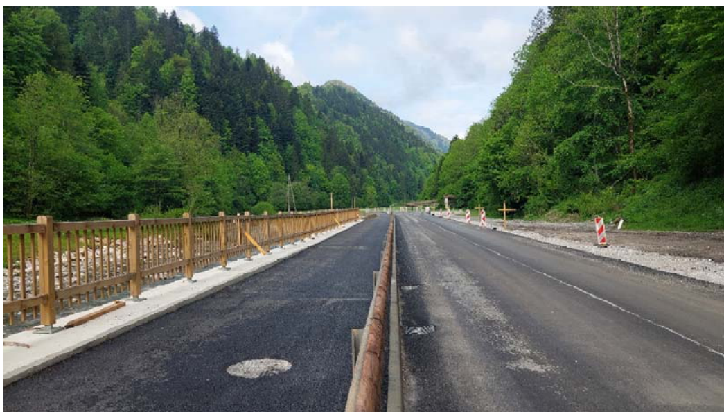
Slika 22: Asfaltiranje ceste (Foto: Karolina Korenčan)
