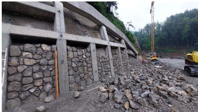
Slika 20: AB-slopi in pozidava (Foto: Ivan Marušič)
