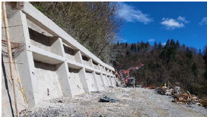
Slika 19: AB-slopi in grede kot oporni ukrep (Foto: Karolina Korenčan)
