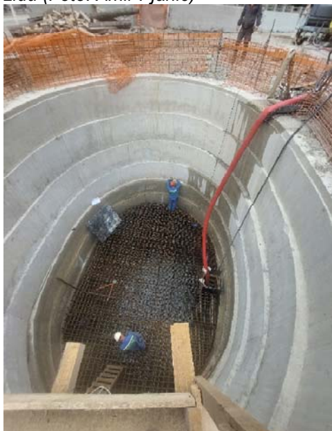
Sliki 9 in 10: Gradnja vmesnega opornika v vodnjaku (Foto: Karolina Korenčan)
