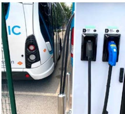
Slika 1: Primer izvedene polnilne postaje na enosmerni tok za polnjenje e busov, vir: E prihodnost, d.o.o.
