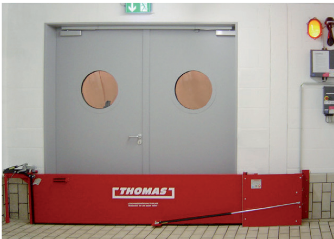
Slika 6: Polavtomatska bariera za požarno vodo (vir: www.visit.suissepublic.ch )
