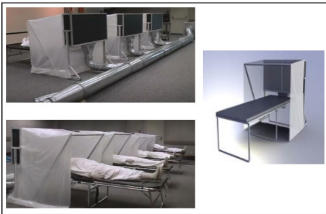
Slika 6: Učinkovita rešitev začasnih izolacijskih sob na odgovor bolezni COVID-19 – Ventilacijsko vzglavje 3
